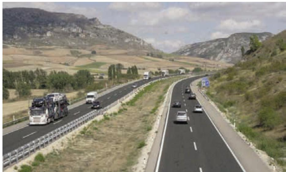
**La supresión del peaje en el tramo Ameyugo-Armiñón obligo a la ampliación a tres carriles de la autopista al ser, según los informes técnicos, incapaz de absorber el aumento del tráfico pesado proveniente de la N-I**
